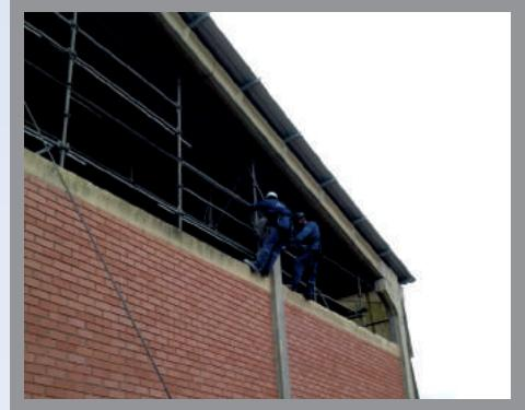
Instalação de sistema de SPDA (sistema de proteção contra descargas atmosféricas na parte superior do prédio, aterramento e fixações).
